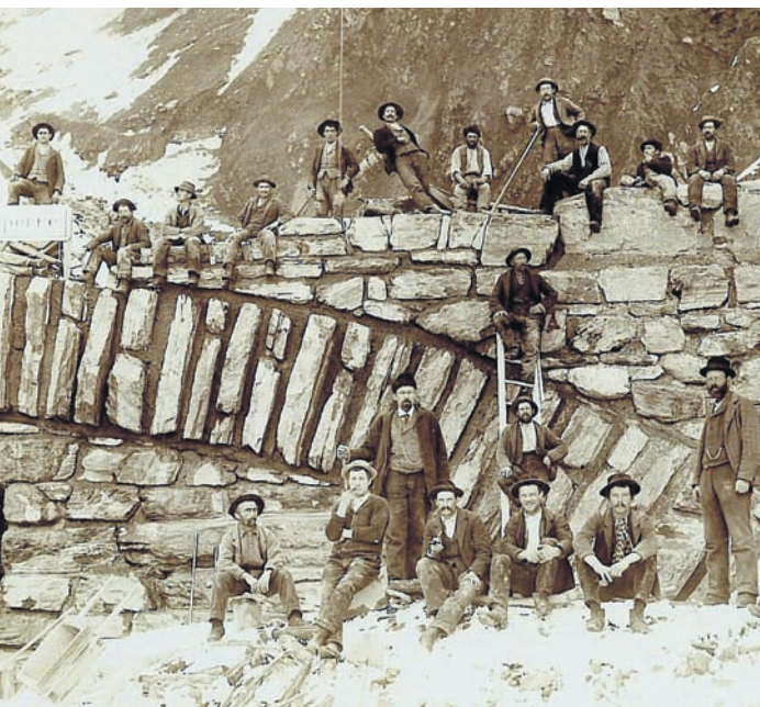
Errichtet wurden sie vor hundert Jahren. B.KISTER/TIEFBAUAMT KT. BERN
